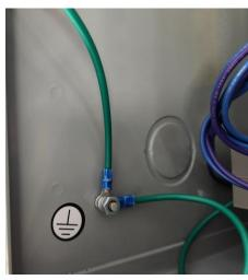
CONNECT GROUND CABLE (GREEN CABLE) TO INSIDE OF PANEL ENCLOSURE, INSTALL ON TOP OF EXISTING GREEN CABLE AND FASTEN SECURELY
